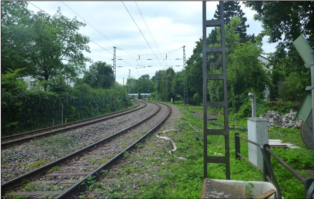
Abbildung 3: Blick von Osten auf den Planungsraum (Gleisbereich) westlich des BÜ Hasenweidweg mit angrenzenden Ruderalflächen sowie Gehölzstrukturen und Einzelbäumen (Foto: AFRY Deutschland GmbH, 2019)
