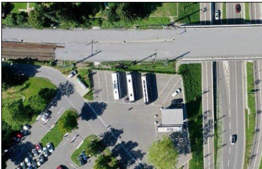
Abbildung 1: Luftbild zur BE-Fläche (Busparkplatz südwestlich der EÜ Langenweg) (DB Netz AG, 2020)
