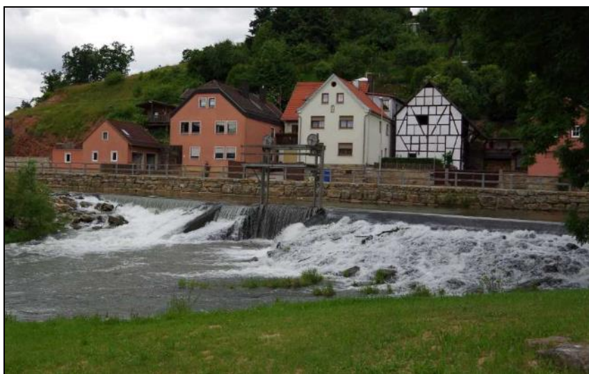
Abb. 19: Nicht durchgängiger Fischaufstieg an der Wehranlage der Mauermühle in Unterebersbach unterhalb Befischungsstrecke 3 (Foto Dr. W. SILKENAT 2018)
