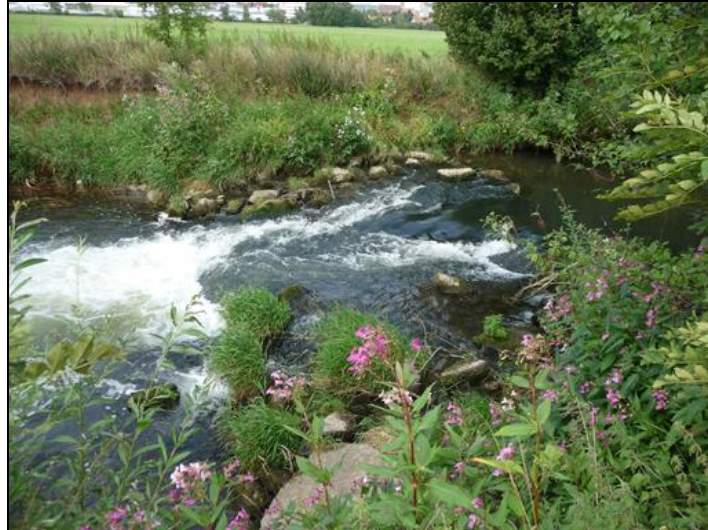
Abb. 18: Sohlrampe zur Sohlsicherung am Beginn der Befischungsstrecke 5 im Naturschutzgebiet Saalewiesen zwischen Bad Neustadt a. d. Saale und Salz, die insbesondere für Fischarten wie die Mühlkoppe nur eingeschränkt passierbar ist. (Foto M. KOLAHSA 2012)
