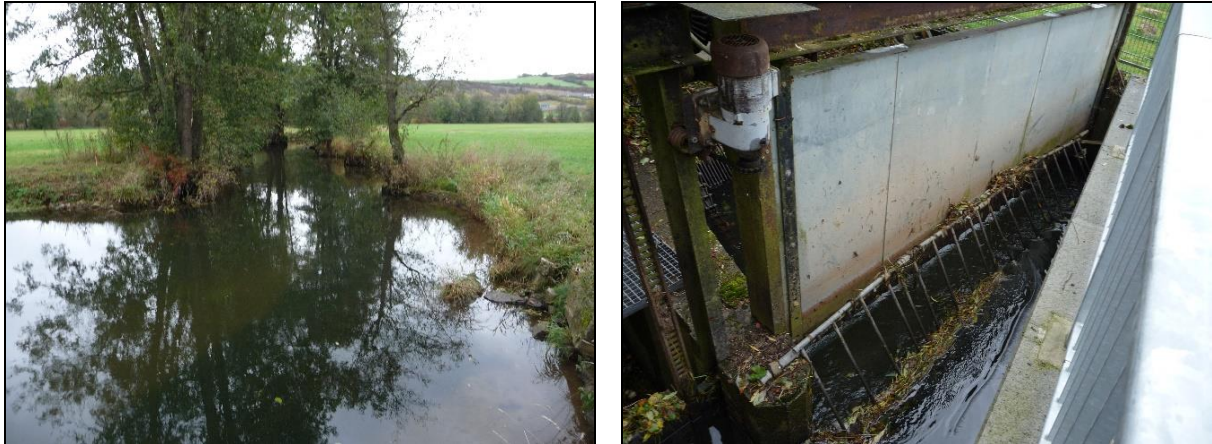
Abb. 20: Zulauf zur Herschfelder Mühle links: Gestauter Gewässerabschnitt rechts: Turbinenzulaufbereich mit Grob- und Feinrechenbereich (Fotos M. KOLAHSA 2011)
