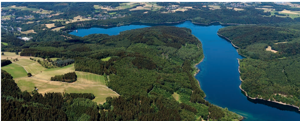
Blick über die Wiehlstalsperre
