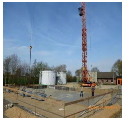
Bau der Klärgasanlage in Lengede
