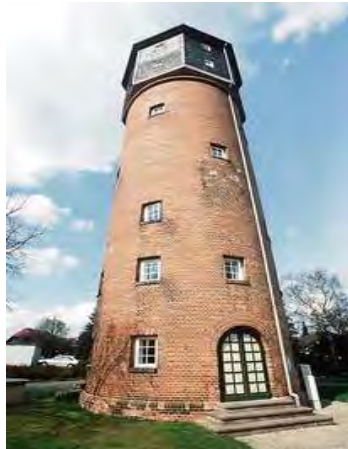
Wasserturm Groß Lafferde
