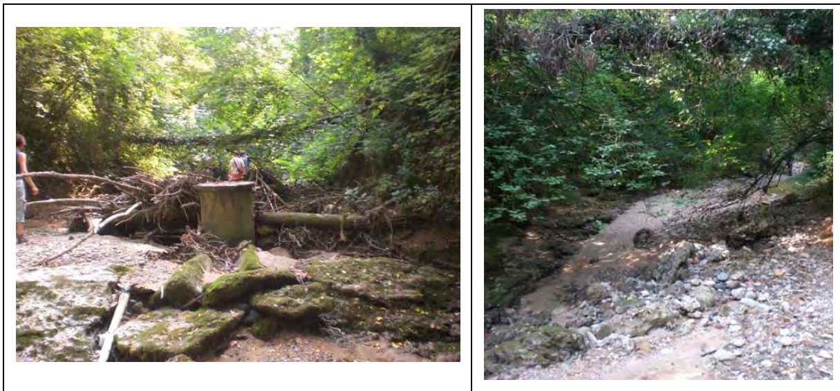
FIGURA 2.10 MATERIALE TRASPORTATO DURANTE LE PIENE DAL TORRENTE ED ACCUMULATO A RIDOSSO DI UNA COLONNA D'ISPEZIONE DEL COLLETTORE FOGNARIO (A SINISTRA). TRATTO IN ASCIUTTA DEL TORRENTE (A DESTRA) (ARCHIVIO CSBA, 2009).
