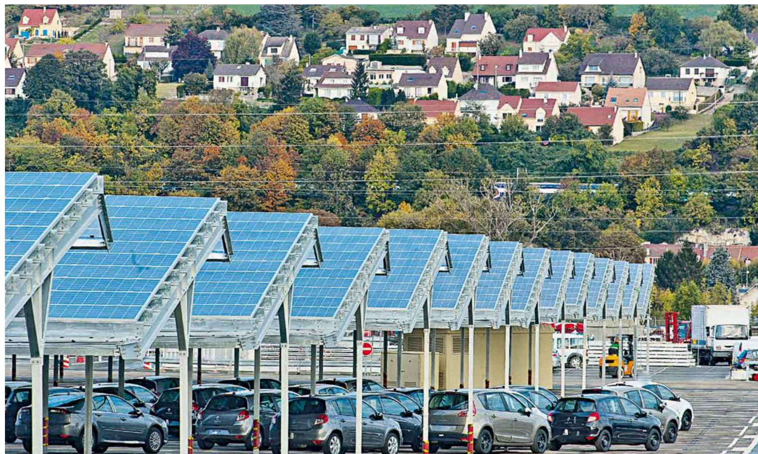
Renault lance le plus grand projet photovoltaïque du monde dans le secteur automobile : 450 000 m 2 de panneaux solaires sur le toit de nos usines françaises. Ici, l'usine de Flins.
