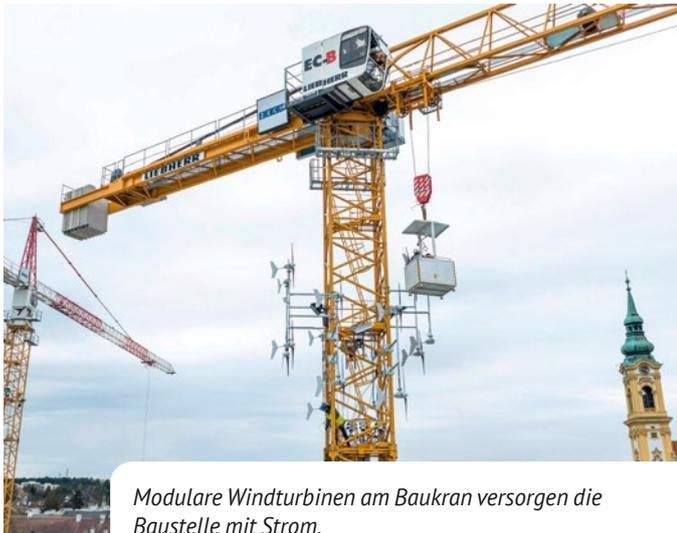
Modulare Windturbinen am Baukran versorgen die Baustelle mit Strom.
