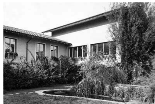
Abbildung 23: Hans Hofmann, Eigenheim Zürich, Südansicht, Aufnahme 1985
