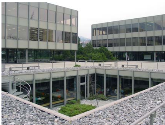
Abbildung 68: Max Schlup, Gymnasium Ländtestrasse, Zentraler Innenhof, Aufnahme 2002
