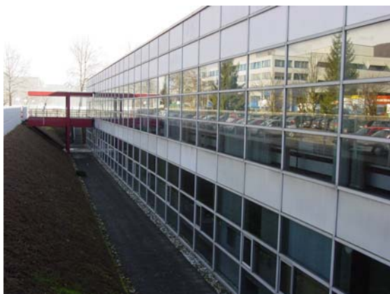
Abbildung 121: Alfons Barth & Hans Zaugg, Schweizer Buchzentrum, Hägendorf, Eingangsfassade, Aufnahme 2002
