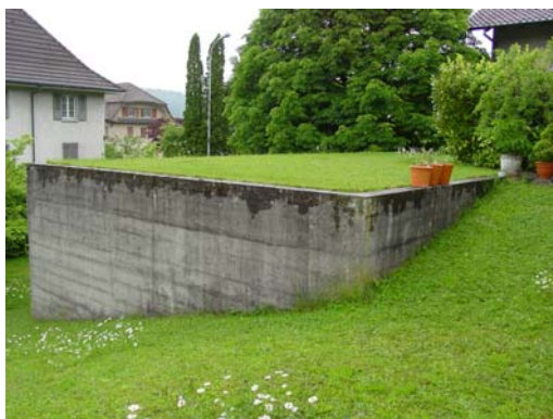
Abbildung 30: Alfons Barth, Garagenanbau, Schönenwerd, Ansicht vom Garten, Aufnahme 2002
