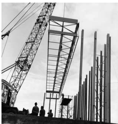
Abbildung 41: Franz Füg, Kirche St. Pius, Meggen, Montage des Stahlbaus
