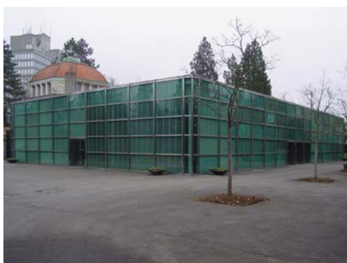
Abbildung 86: Alfons Barth & Hans Zaugg, Abdankungshalle, Aarau, Ansicht von Südwesten, Aufnahme 2002
