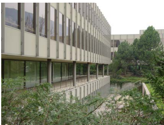
Abbildung 69: Max Schlup, Gymnasium Ländtestrasse, Innenhof Deutsches Gymnasium, Aufnahme 2002
