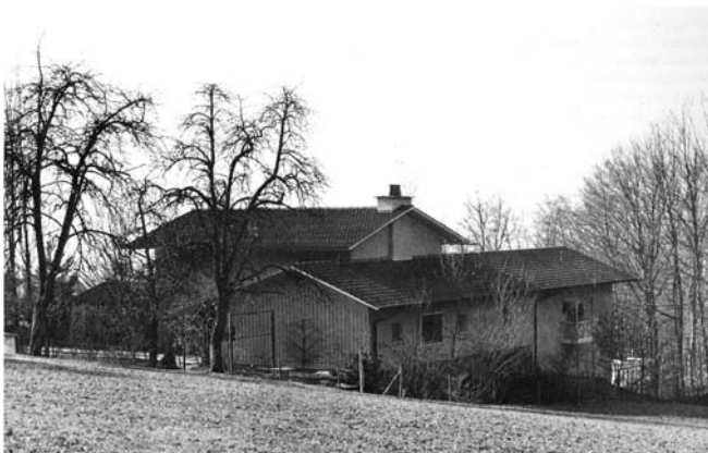
Abbildung 11: Hans Hofmann, Eigenheim Hofmann, Zürich, 1940/41
