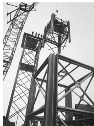
Abbildung 47: Franz Füg, Kirche St. Pius, Meggen, Montage des Turms
