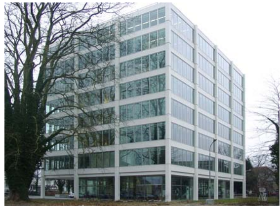
Abbildung 2: Alfons Barth, Kantonsschule Steinmannhaus, Aarau, 1961–1969, Aufnahme 2002
