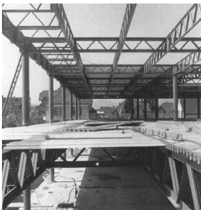
Abbildung 24: Fritz Haller, Höhere Technische Lehranstalt, Brugg-Windisch, Rohbau, Aufnahme 1965
