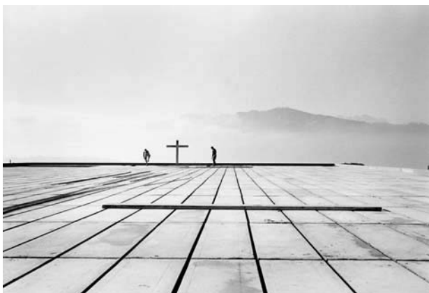
Abbildung 45: Franz Füg, Kirche St. Pius, Meggen, Montage der Leichtbetonplatten des Dachs
