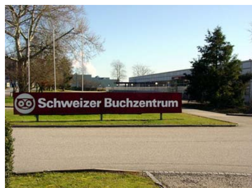
Abbildung 96: Alfons Barth & Hans Zaugg, Schweizer Buchzentrum, Hägendorf, 1974–1975, Eingangsfassade, Aufnahme 2002
