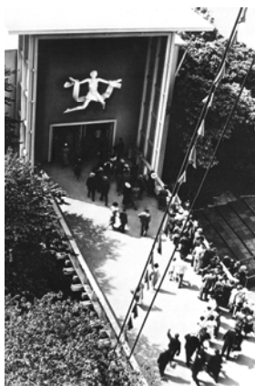
Abbildung 9: Eingang zur Höhenstrasse
