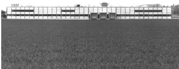
Abbildung 4: Fritz Haller, Betriebsanlage USM, Münsingen, Stahlbausystem MAXI
