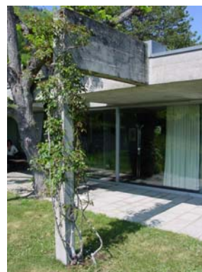
Abbildung 41: Max Schlup, Eigenheim, Biel, Auskragende Stütze, Aufnahme 2002
