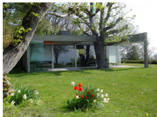
Abbildung 43: Max Schlup, Eigenheim, Biel, Westfassade, Aufnahme 2002
