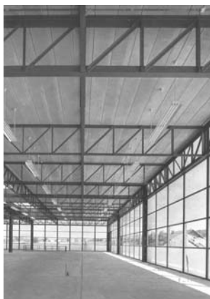
Abbildung 3: Fritz Haller, Betriebsanlage USM, Münsingen, Stahlbausystem MAXI
