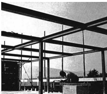
Abbildung 51: Hans Zaugg, Eigenheim, Olten, Montage des Stahlbaus, Aufnahme 1955
