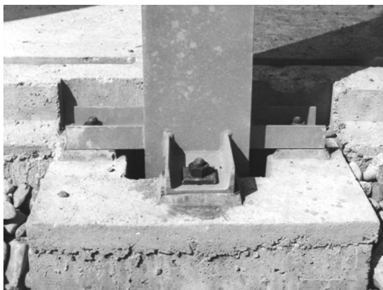
Abbildung 40: Franz Füg, Kirche St. Pius, Meggen, Montage der HEB 240 Stützen
