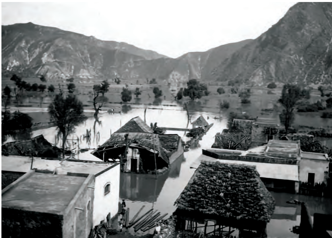
Figura 1. Inundación registrada en la comunidad de San Cristóbal. Foto: Archivo Histórico del Agua.
