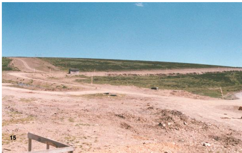
Fig. 15.- Desmontes en Fonte da Cova-Campo Romo (VII-2000). Sin comentarios.
