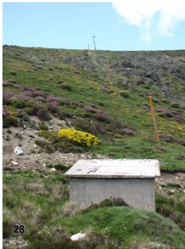
Fig. 28.- Restos del tendido de telesquíes, bajando hacia Foyo Grande, del antiguo proyecto "Montañas de Trevinca". (V-2011).
