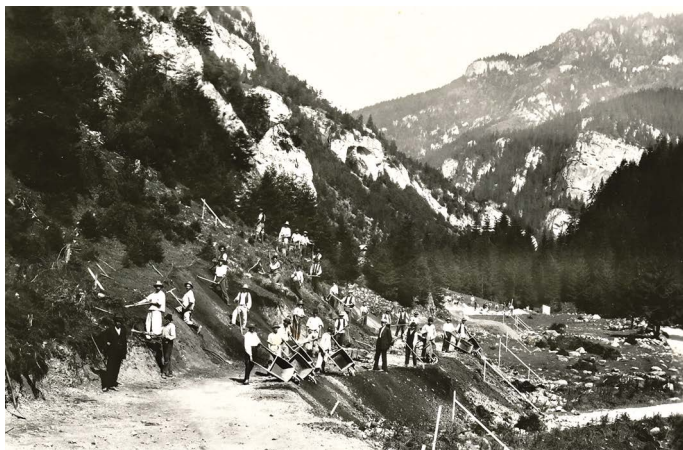
Obr. 5: Budování přístupové silnice do Demänovské doliny, kde byly Demänovské jeskyně slavnostně otevřeny v roce 1924. Archiv Podboráckého muzea v Tišnově, požůstalost A. Krále. – Building an access road to Demänovská Valley, where the Demänovské Caves were ceremonially opened in 1924. Archive of the Podborácké Museum in Tišnov, Legacy of A. Král.
