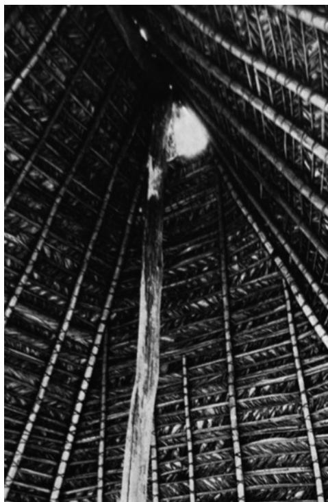
Fig 3. Detalle de la estructura de la casa, vista interior.
