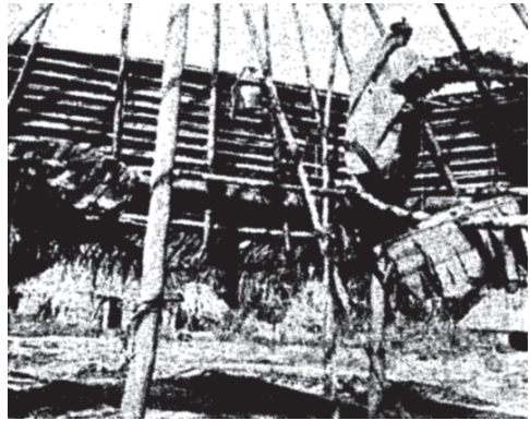
Fig. 3. Casa en construcción
