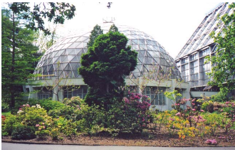
Новозбудований оранжерейний комплекс
