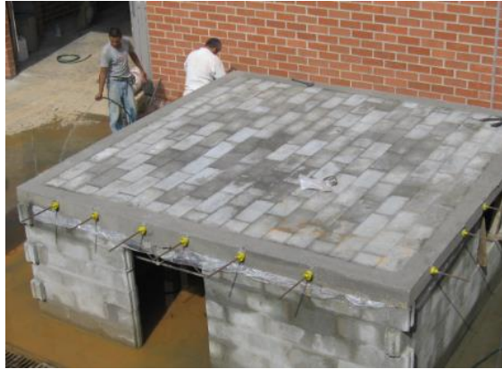
Figura 4. Sistema de mampostería postensada (Bonett, 2014).
