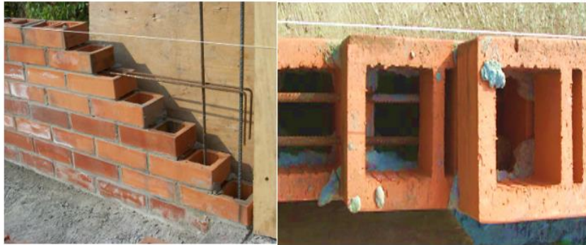
Figura 3. Acero de refuerzo en un muro de mampostería reforzada interiormente (Flores, 2007).
