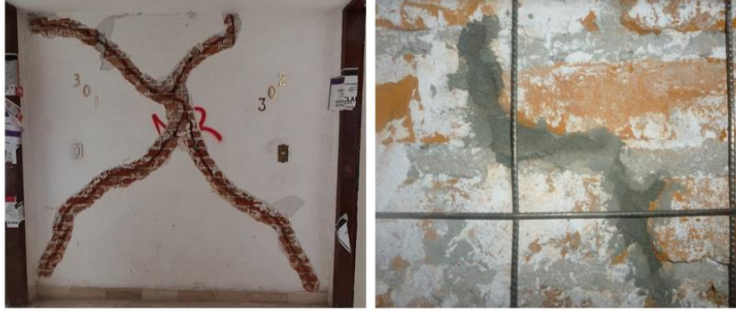
Figura 14. Preparación del muro para inyección de grietas (izq.) e inyección de grietas con mortero de cemento (der.) (Archivo fotográfico proyecto ConTex, 2018).
