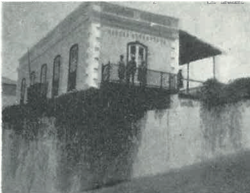
Novas instalações de S. Filipe com os obreiros do Fogo
