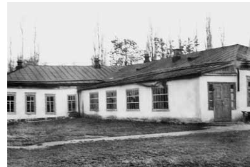
Рис. 3. Псебай. Дом ВКО. Управление ВКО располагалось в отремонтированных казармах 75-го пехотного Севастопольского полка. После постройки дома Великого Князя здесь собиралась охотничья команда егерей, осуществлялись экспедиционные сборы. Фото конца 50-х гг. XX в. [26]
