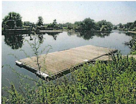
Abbildung 3: Bestandssteeg. Foto: Rietmann Beratende Ingenieure PartG mbB, 2015
