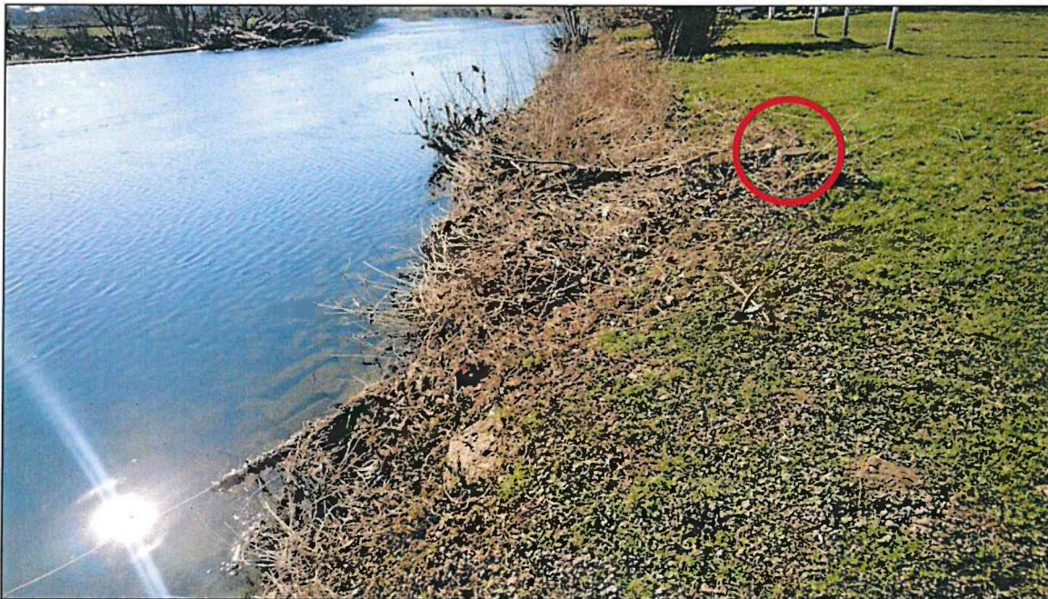
Abbildung 4: Seilfundament außerhalb der Uferlinie.
