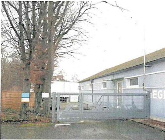
Abbildung 2: Zufahrt auf das Grundstück des Rudervereins, ca 5 m Breite in Richtung Sieg immer weiter verjüngend auf ca. 2,50 m Breite am Übergang zum Bestands-Bootssteg. Foto: Rietmann Beratende Ingenieure PartG mbB, 2022
