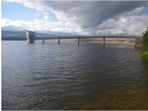
▲ Vue de la zone de prélèvement depuis la rive droite à proximité du point o2
