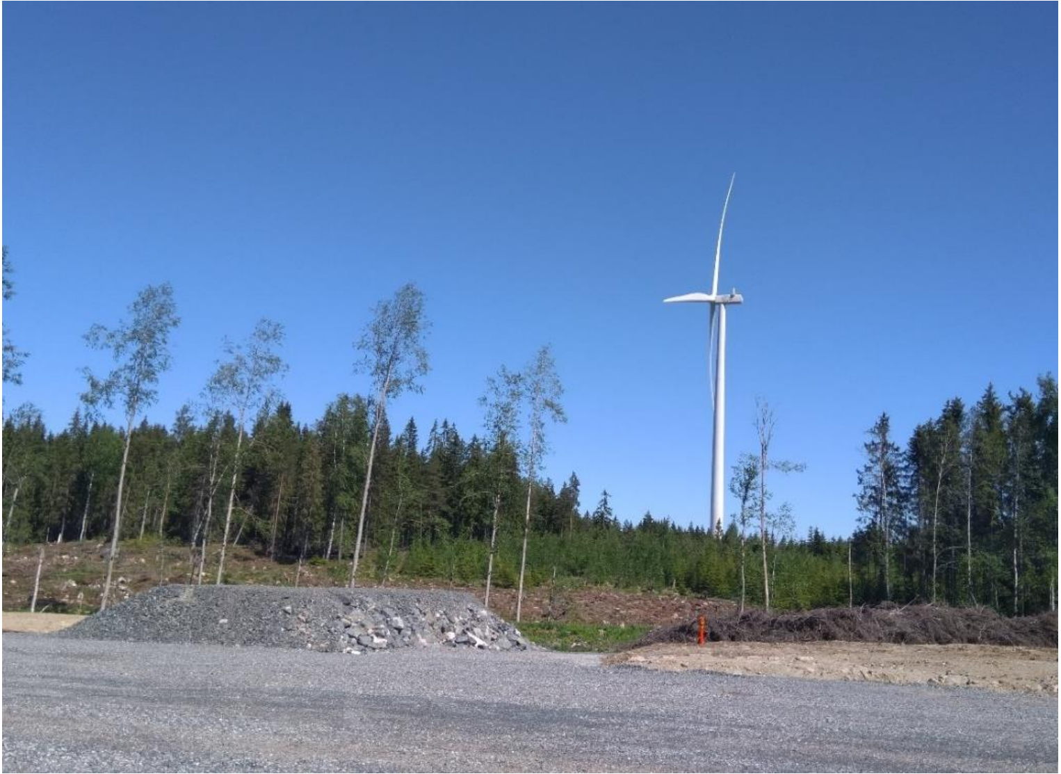
Kuva 3. Humppila-Urjalan alueella sijaitseva tuulivoimala. Napa-/pyyhkäisykorkeus on 135 / 210 metriä. (Valokuva: FCG 2022)
