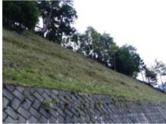
写-75 切取法面保護した草相状況
