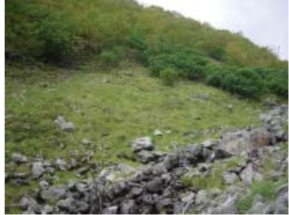
写-32 藪沢の分岐付近の様子(食圧が高い)
