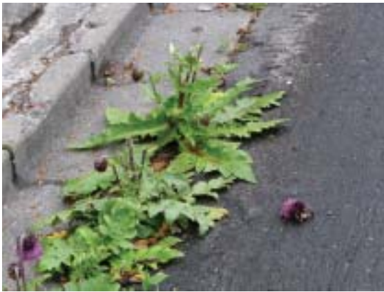
写-74 路肩の植物の被害状況
