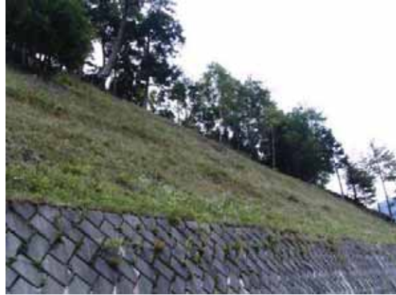
写-75 切取法面保護した草相状況
