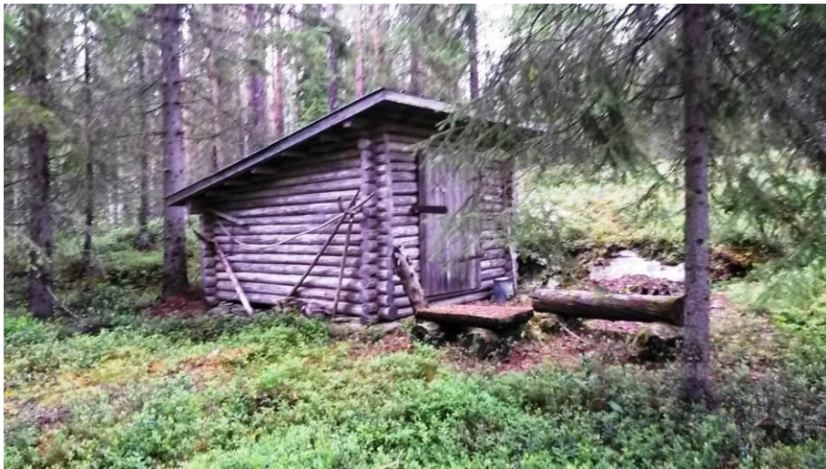
Kuva 19 Pieni varasto järven eteläpäässä
