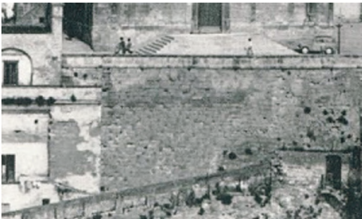
Fig.8 Il muraglione di Piazza Duomo in una foto del 1950 circa. Il crollo dello stesso avvenuto nel febbraio 1972 sembra essere dipeso dalla visibile erosione e indebolimento dei conci di calcarenite che costituivano il paramento esterno dovuta all'evaporazione dell'acqua di umidità. (foto Rivista Basilicata n1, a.1973)
