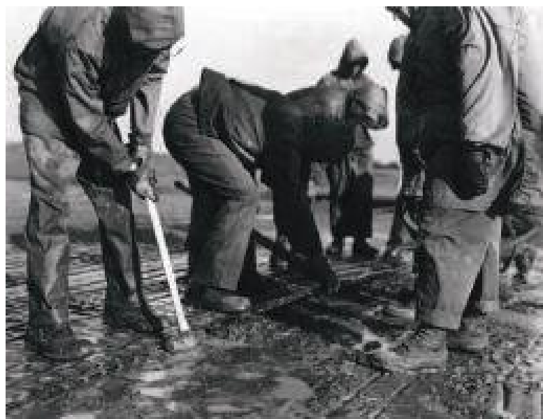
Fig.5 - Equipaggio militare durante le fasi di assemblaggio delle lastre PSP - Pierced Steel Planks (www.airspacemag.com)
