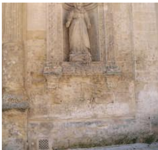
Fig. 2 (sopra) e 3 (a destra) - Dettaglio del settecentesco prospetto della chiesa di santa Chiara. Il degrado dovuto all'evaporazione dell'acqua di umidità è diffuso sull'intera facciata ed è decrescente verso l'alto. In basso uno dei tre fori quadrati sistemati alla base per contrastare il fenomeno, si rivelano inutili. (foto C. Di Lena)
