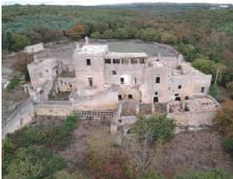
Fig. 1 - Foto aerea della masseria vista da Sud, esposizione ideale anche per l'orientamento degli apiari visibili in basso a sinistra (Archivio Antros)
