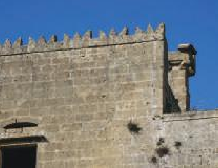
Fig. 3 - Dettagli architettonici (foto R. Paolicelli)
