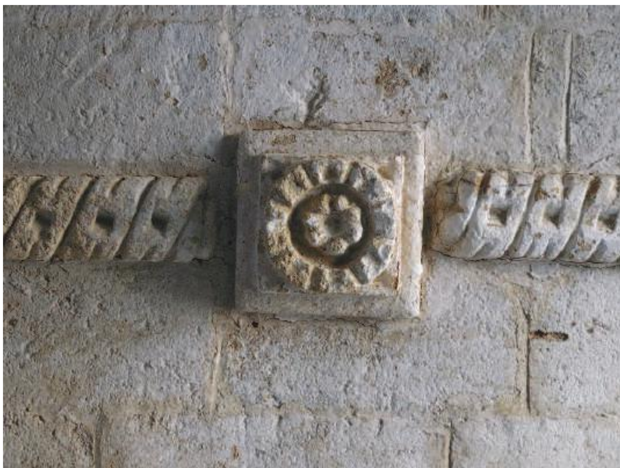
Fig. 8 - Cordonatura decorata presente nella parte centrale di una volta a botte al primo livello (foto R. Paolicelli)
