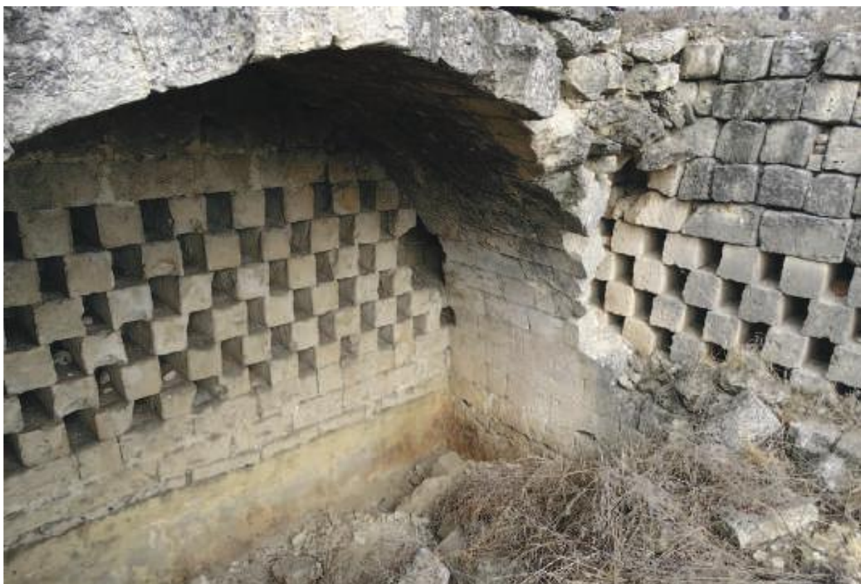
Fig. 10 - Resti di una colombaia in muratura ubicata nei pressi della Gravinella (foto R. Paolicelli)
