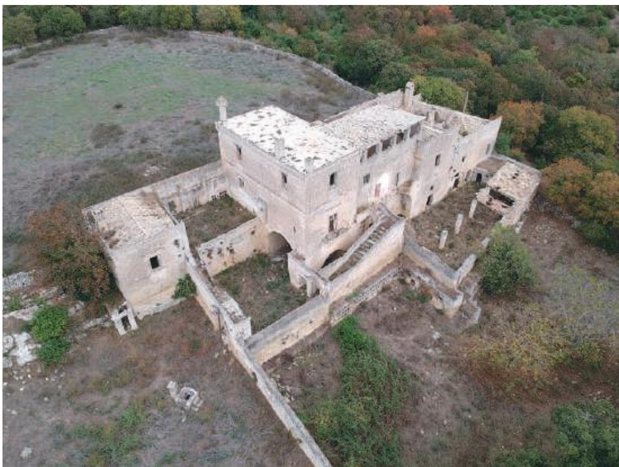
Fig. 6 - Foto aerea della masseria vista da Sud-Ovest (Archivio Antros)
