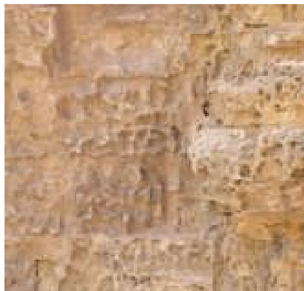
Fig. 2 (sopra) e 3 (a destra) - Dettaglio del settecentesco prospetto della chiesa di santa Chiara. Il degrado dovuto all'evaporazione dell'acqua di umidità è diffuso sull'intera facciata ed è decrescente verso l'alto. In basso uno dei tre fori quadrati sistemati alla base per contrastare il fenomeno, si rivelano inutili. (foto C. Di Lena)
