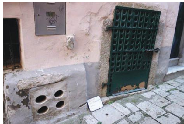
Fig. 7 - Ingresso di una cantina privata a Venosa protetta con porta in PSP - Pierced Steel Planks (Foto J. G. Sanchez).
