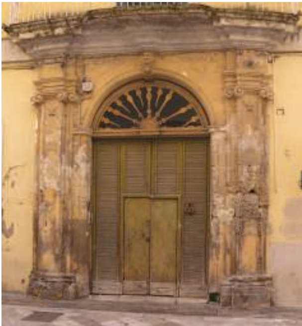
Fig. 4 - Il portale del palazzo Contuzzi in via del corso n. 46 costruito tra fine Settecento e inizio Ottocento. Il degrado dovuto all'evaporazione dell'acqua interessa soltanto la parte centrale delle due paraste del portale e la base (originariamente entro terra) di sinistra in quanto l'intonaco cementizio nella parte inferiore delle paraste ha impedito l'evaporazione dell'acqua. (foto Di Lena)
