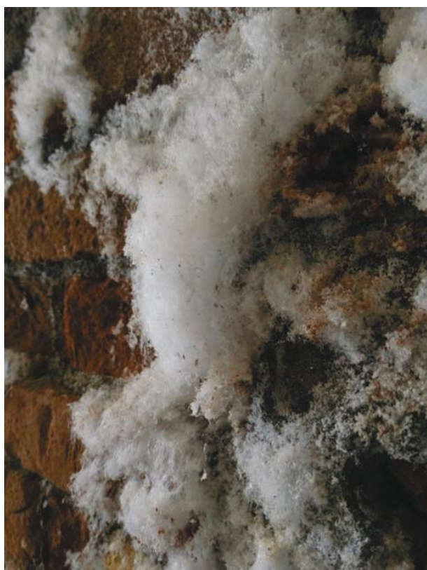
Fig. 1 - a) (a lato) Efflorescenza di salnitro su di un muro; Fig. 1 - b) (sotto) Efflorescenza di salnitro su pavimento (foto di R. Paolicelli)
