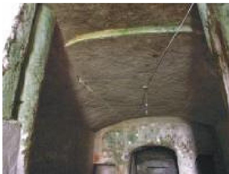
Fig. 3 - Interno della cantina di vico S. Agostino n. 13, erroneamente interpretato come chiesa di S. Placido da La Scaletta (foto A. Fontana)
