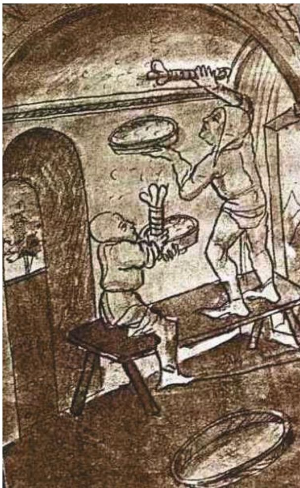
Fig. 2 - Raschiatura del salnitro da un muro umido (Fonte: https://ilblogdel-lasci.wordpress.com/tag/salnitro/ )
