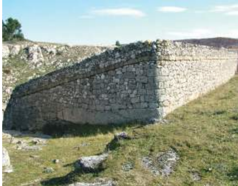
Fig. 34 - Struttura muraria di pecchiara. Contrada Trasanello (foto G. Lionetti, anno 2003)
