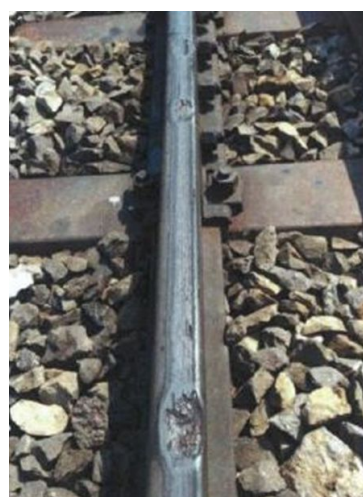
Abbildung 2: Flachstellen auf Schiene
