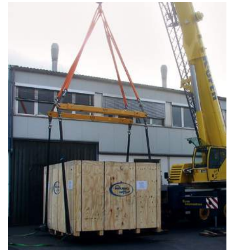
Spreiztraversen-Gehänge Anschlag unterhalb des Lastschwerpunktes
