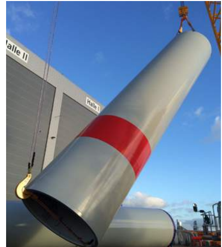
120t Hebevorgang einer Turmsection mit Axzion J-Hook und Axzion Pully inkl. Turmstabilisierung
