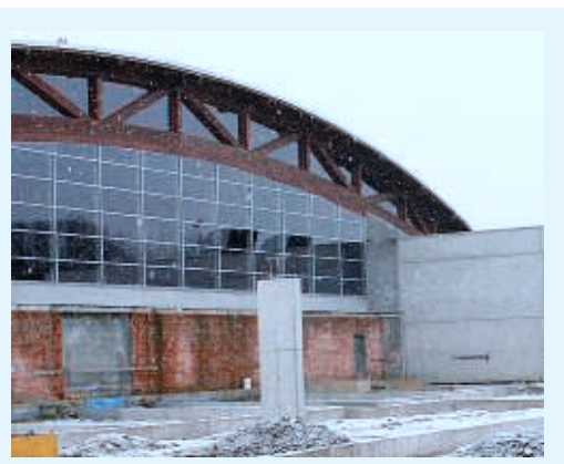
Il cantiere per i nuovi spogliatoi
