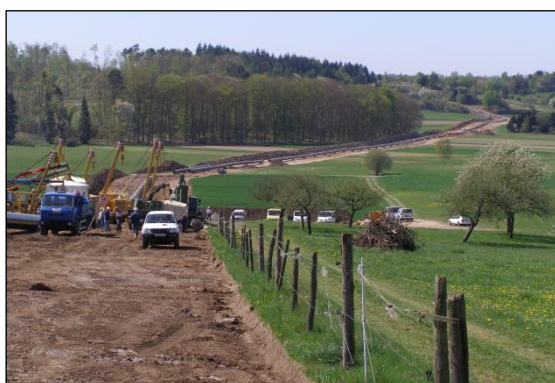
während des Leitungsbaus (Quelle: OGE)
