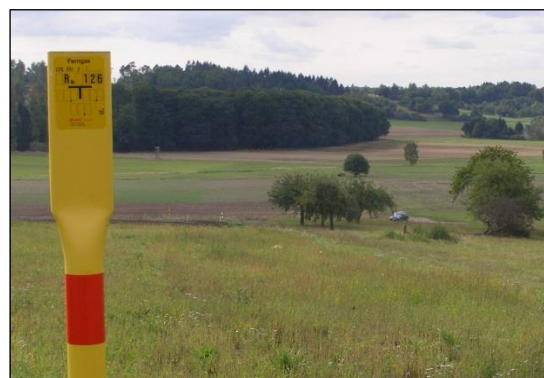
nach dem Leitungsbau (Quelle: OGE)
