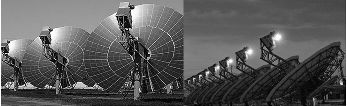
2.55. att. Stirling Energy Systems izstrādātie Stirlinga šķīvji.
