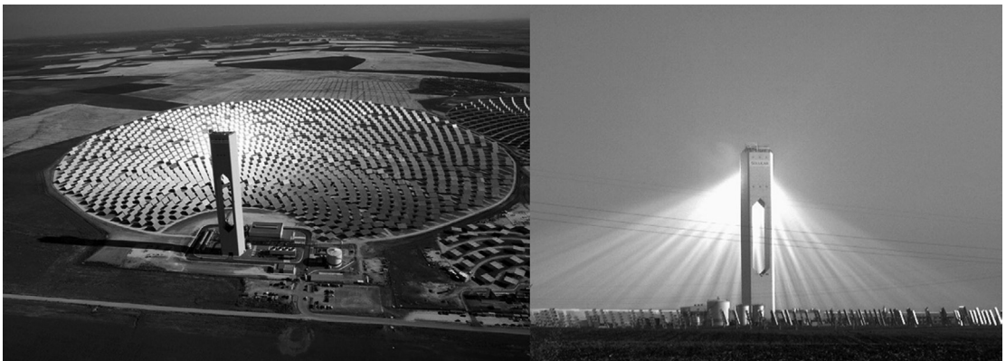
2.57. att. Solārā torņa elektrostacija Sevilā, Spānija, 11 MW.
