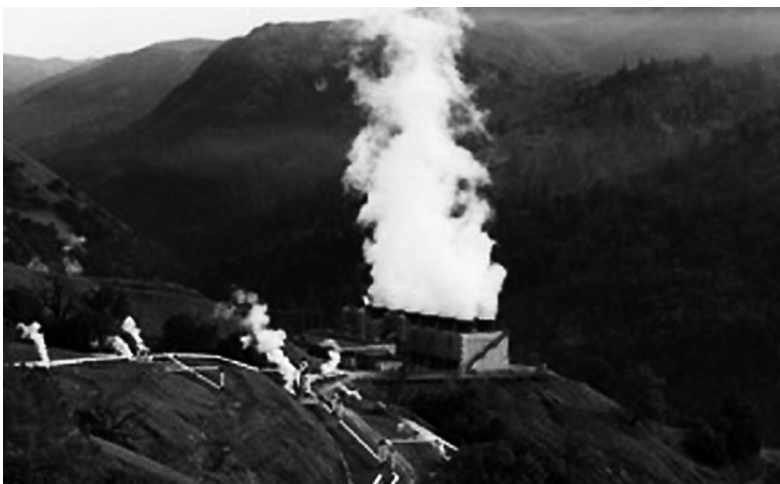
2.42. att. ASV, Kalifornija, ģeotermālā elektrostacija kompleksā The Geysers.
