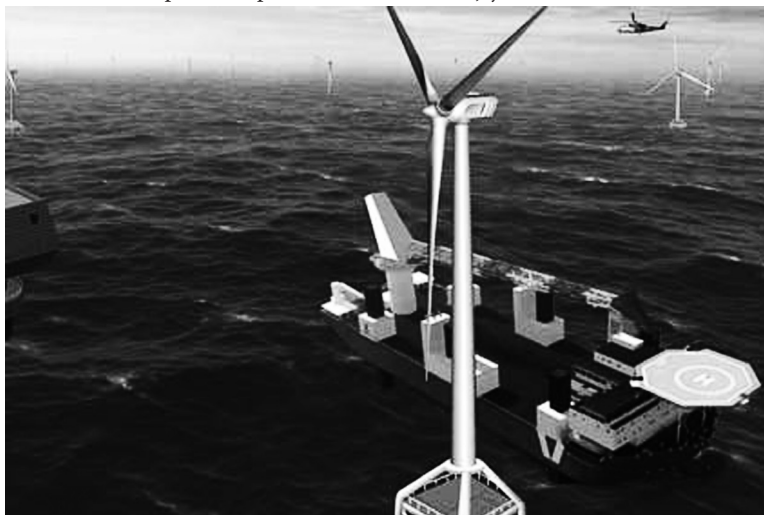
2.36. att. Jūrā drefējošas vēja turbīnas būvniecības darbi.
