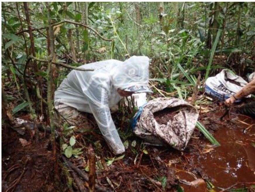
ダムのための土嚢作り
