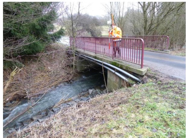
Abbildung 15: Vermessung von Brücken (Bleichbach, Foto: eepi)
