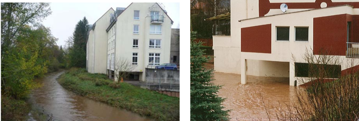
Abbildung 42: Aufgeständerte Gebäude mit flutbaren Erdgeschossen (Fotos: Schmidt, LUA)
