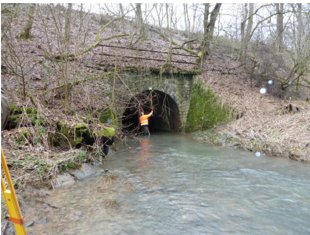
Abbildung 14: Vermessung von Durchlässen (Betzelsbach (Foto: eepi)
