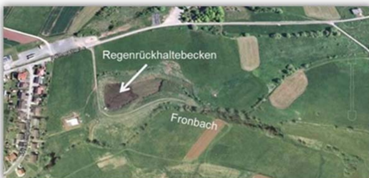
Abbildung 40: Regenrückhaltebecken im Seitenschluss des Fronbaches zum Rückhalt von Außengebietswasser
