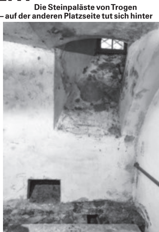
Keller am Landsgemeindeplatz in Trogen mit Wasserrinne und Belüftung. (Bild: Su.)
