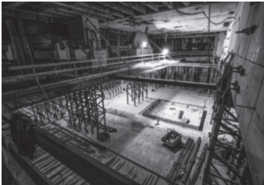
Der Tiefpunkt: UG25 im Bau. (Bild: hrt)
