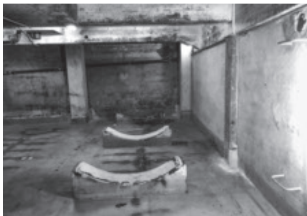
Einer der ehemaligen Öltank-Keller. (Bild: Su.)
