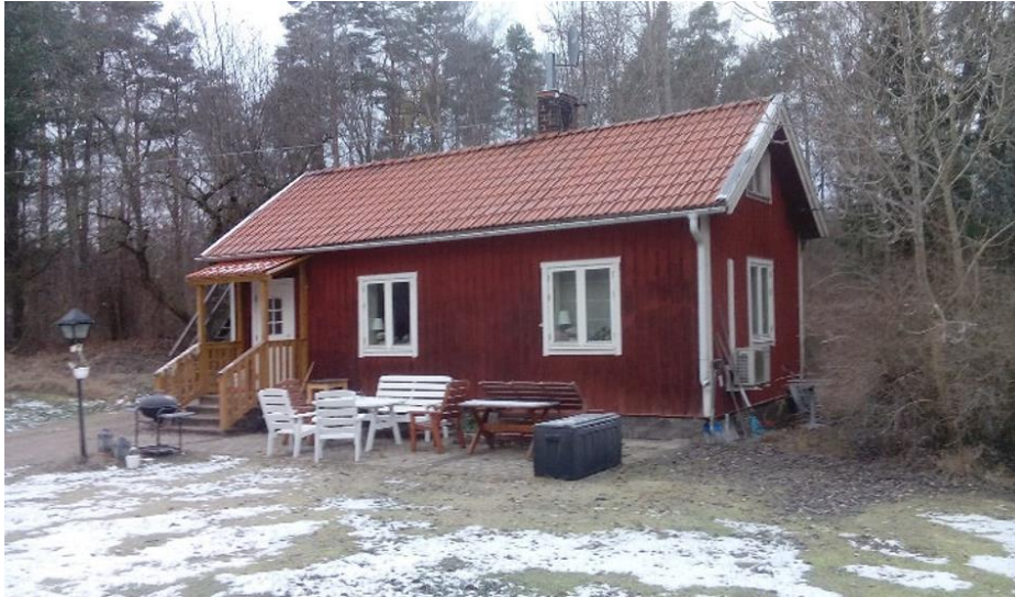
Befintlig huvudbyggnad, fasad mot syd
