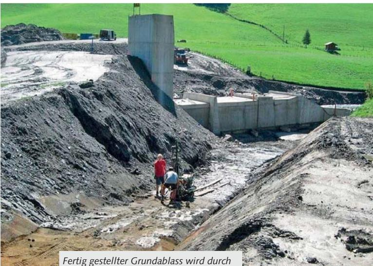
*Fertig gestellter Grundablass wird durch Rückhaltedamm überschüttet*
