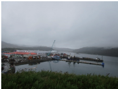
写真 13（穴澗港と新旧工場）
