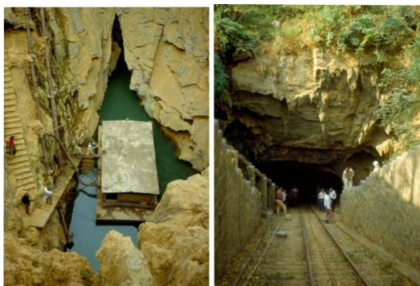
Слика 3. Кина. Покретна каптажа која прати осцилације воде у карстном каналу
