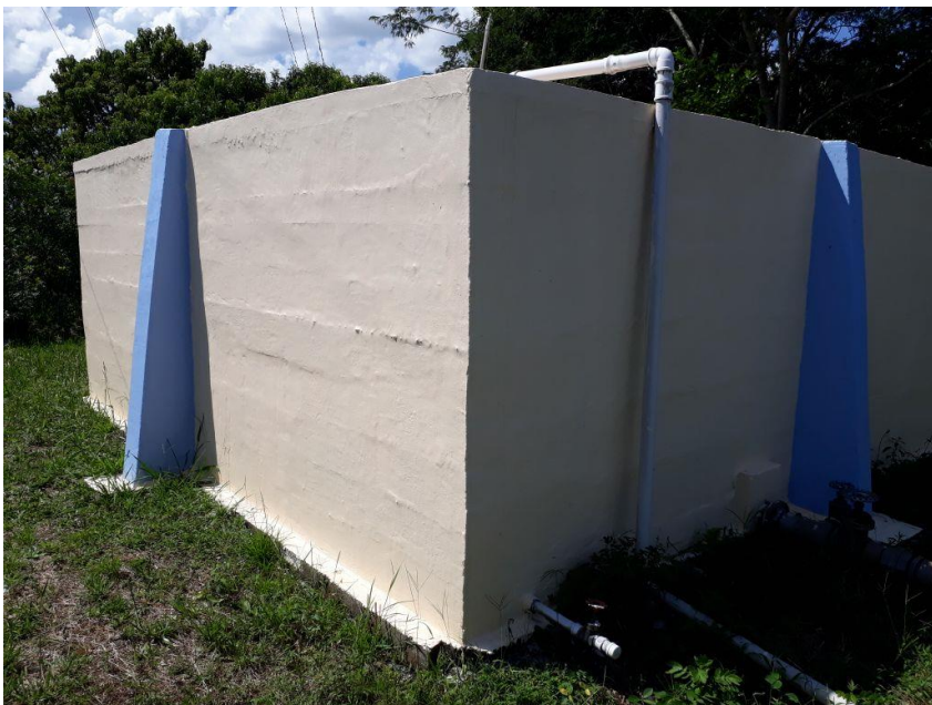
Figura 21. Reservatório 3, situado na rua Valentim Zorzi.
