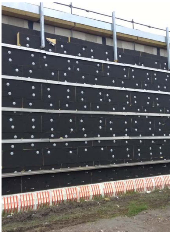
Afbeelding 2 Links het gebouw opgetrokken uit prefab beton en rechts de geïsoleerde buitenschil. Foto's Luc Schaap
