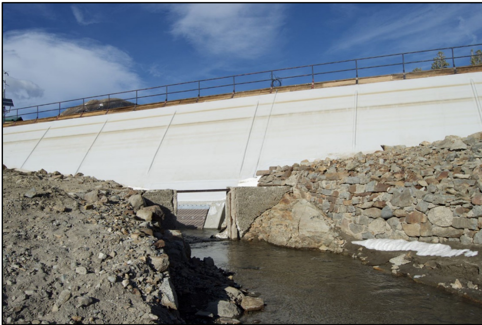
Photo 5.10-4. Tioga Dam Outlet
