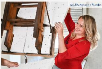
DIY Dachbodentreppe dämmen
