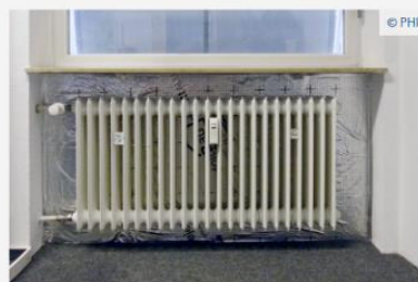
DIY: Dämmplatten hinter dem Heizkörper
