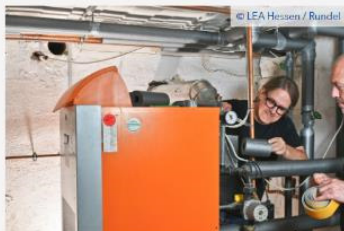
DIY Heizungsrohre dämmen
