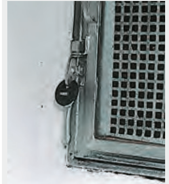
Kellerfensterschloss KFS 20: Kette und Riegel sicher arretiert Cadenas de soupirail KFS 20 Chaîne et verrou bloqués
