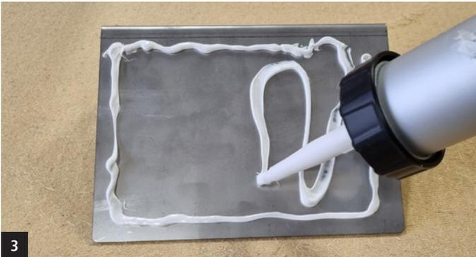
3 FDM WALL auf den Winkel auftragen und rückseitig der STURZBLENDE andrücken (Abstände sh. Verarbeitungsrichtlinie)
