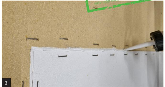
2 Fugen in Fassadenebene mit FDM WALL verschliessen
