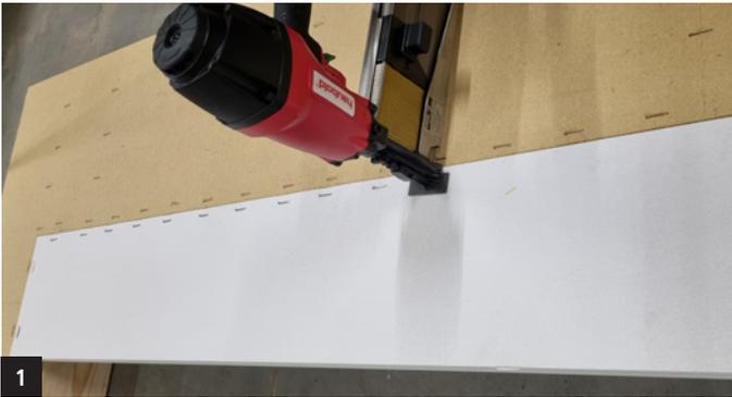
1 STURZBLENDE umlaufend auf halbe Ständer-/ Riegelbreite klammern
