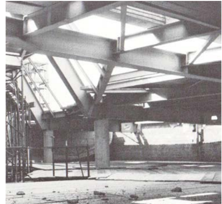
Diese Stahlkonstruktion dient als Primärtragwerk. Das Sekundärtragwerk besteht aus armierten Leichtbetonelementen, die zugleich für die Formgebung des Dachs verantwortlich sind.
