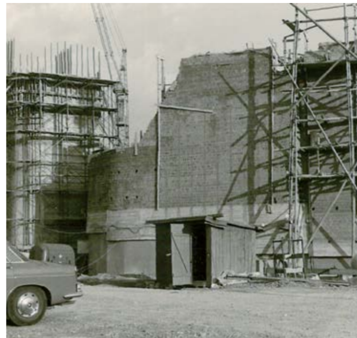
Nur der Kirchturm ist betoniert. Der Rest der Pfarrkirche entstand durch Maurerarbeiten.
