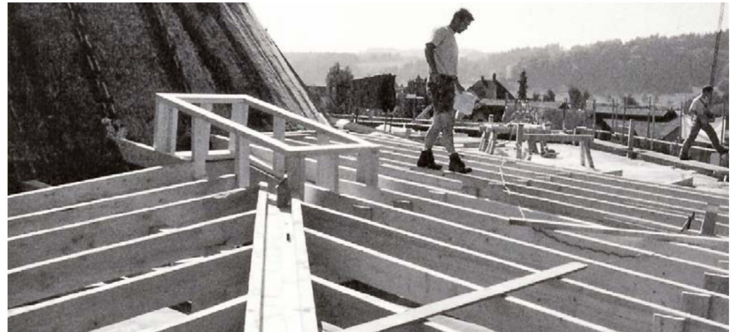
Bei der Dachsanierung im Jahr 2001. Die Tragkonstruktion ist im Holzbau gehalten. Hier zu sehen ist die erste Ebene mit Verlängerungsbauten und Lichtschalen.
