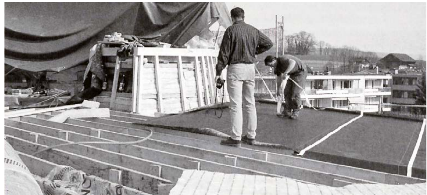
Auf der zweiten Ebene werden die Wärmedämmung und die Unterdachbahn angebracht.
