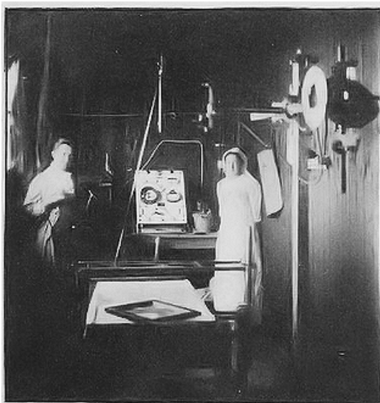
Tavola III: Sala radiografia dell'Ospedale n° 112 di Amiens, installata in un baraccamento (anno 1916). Si nota l'apparecchiatura, il quadro di radiografia, il piede porta ampolla e il trolley.
