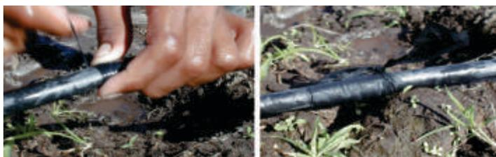
**Fotos 94 y 95.** Reparación de fugas utilizando neumático de bicicleta o moto.
