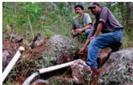
**Foto 9.** Colocación de un tubo para aforar la fuente de agua.
