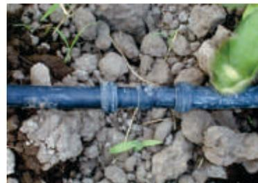
**Foto 93.** Reparación de fuga usando un conector de cinta a cinta.
