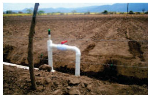
Foto 28. Válvula de aire instalada. Cada válvula de control del paso de agua debe llevar una válvula de aire.
