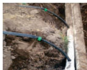
Foto 99. Elevadores de polietileno de 16 mm, comúnmente llamados tubines.
