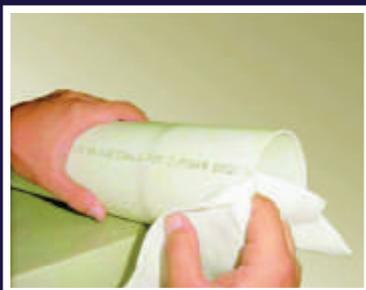
3. Limpie el tubo e interior de la conexión con un trozo de tela limpio y humedecido con limpiador de PVC.
