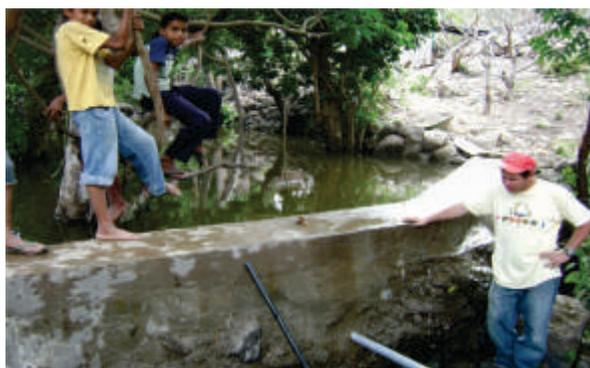
**Foto 3.** Presas permanentes de cemento construidas en quebradas muy pequeñas.
