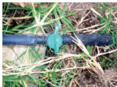
**Foto 59.** Conector válvula de tubín a tubín.
