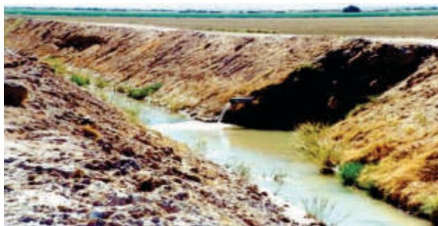
**Foto 112.** Sistema de drenaje que combina la zanja abierta y tubo enterrado (drenaje subterráneo).
