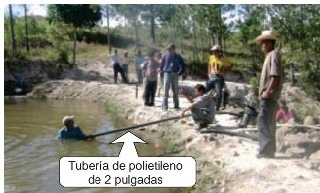
**Foto 6.** Instalación de tubería para conducción del agua de la laguna hacia las parcelas.
