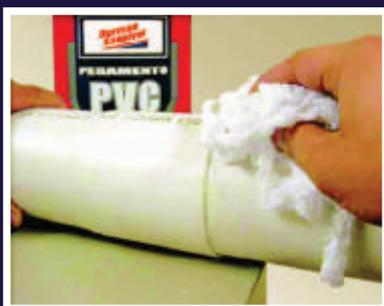
7. Limpie el exceso de pegamento. Espere 2 horas antes de manipular y 24 horas antes de hacer la prueba de presión.
