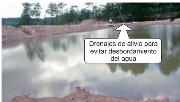
**Foto 7.** Drenaje de auxilio en la borda de la laguna.
