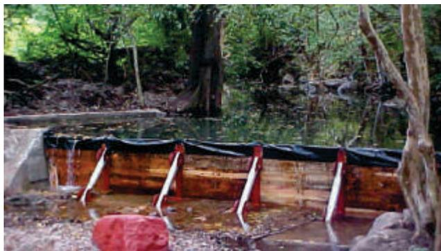
**Foto 1.** Presa provisional de madera en un río para aumentar el nivel de almacenamiento.
