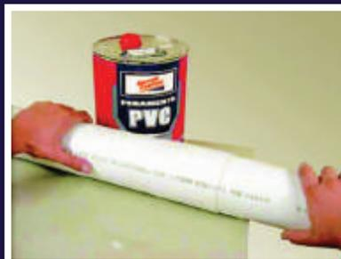
6. Acople el tubo en la conexión mientras el pegamento está húmedo, mantenga juntos 30 segundos para evitar un mal pegue.
