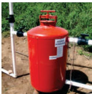
Foto 50. Filtro de arena instalado.
