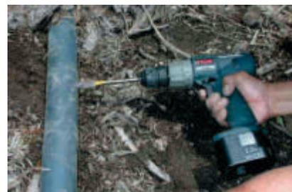
Foto 96. Perforación de tubería.
