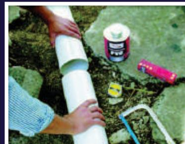
4. Una las piezas en seco, para comprobar que el tubo y el accesorio encajan.
