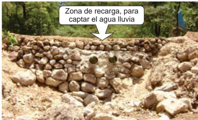
**Foto 5.** Borda de tierra, piedra y cemento construida en un vaso natural.
