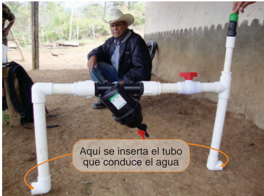
**Foto 103.** Válvula de control armada, con filtro y válvula de aire.
