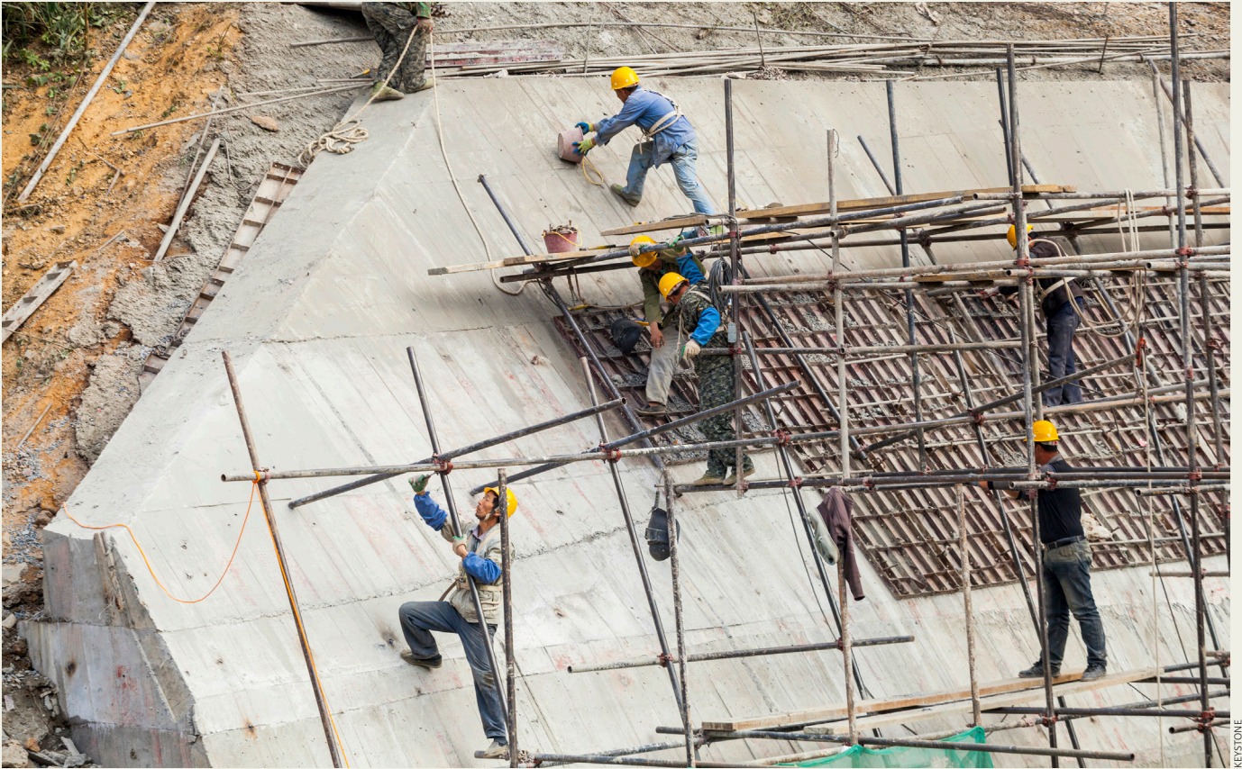
Arbeiter beim Bau eines Staudamms in Laos. Kritiker bemängeln, dass solche Grossprojekte kaum Arbeitsplätze für die Bevölkerung schaffen.
