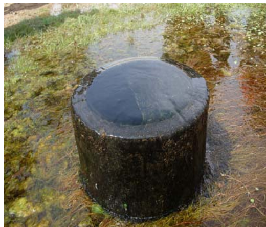
乌兰布和沙漠内部深层承压水自流井
