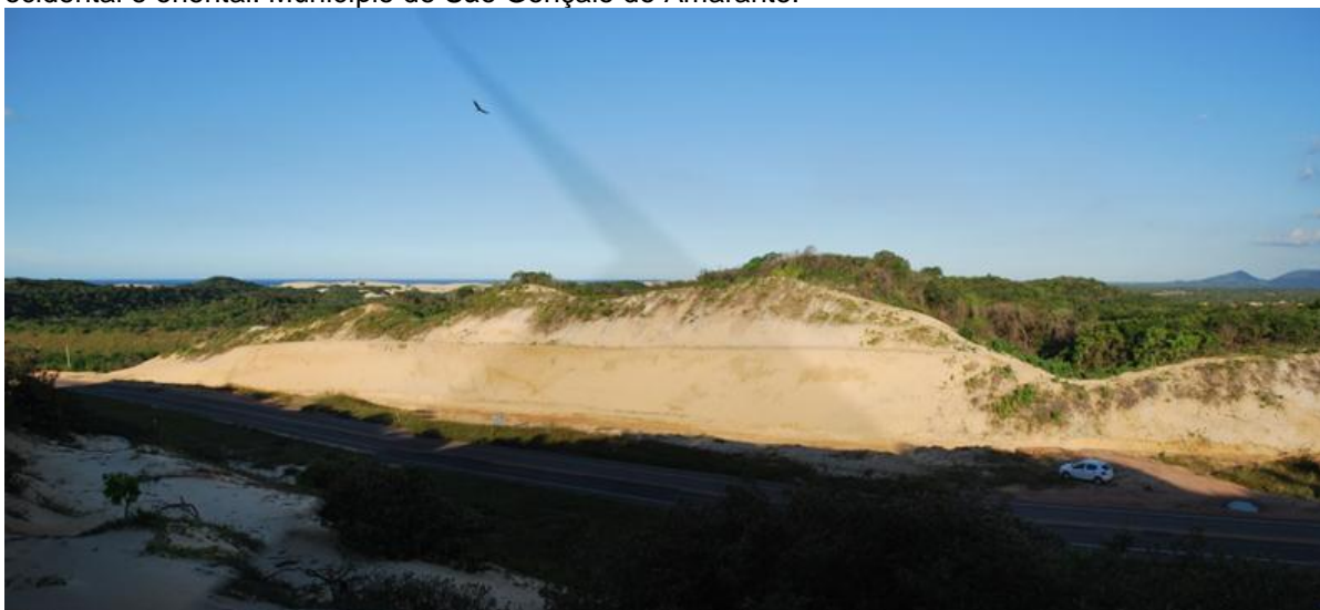
Figura 20 – Rodovia CE-422 que cruza a Estação Ecológica do Pecém, dividindo-a em duas porções, ocidental e oriental. Município de São Gonçalo do Amarante.
