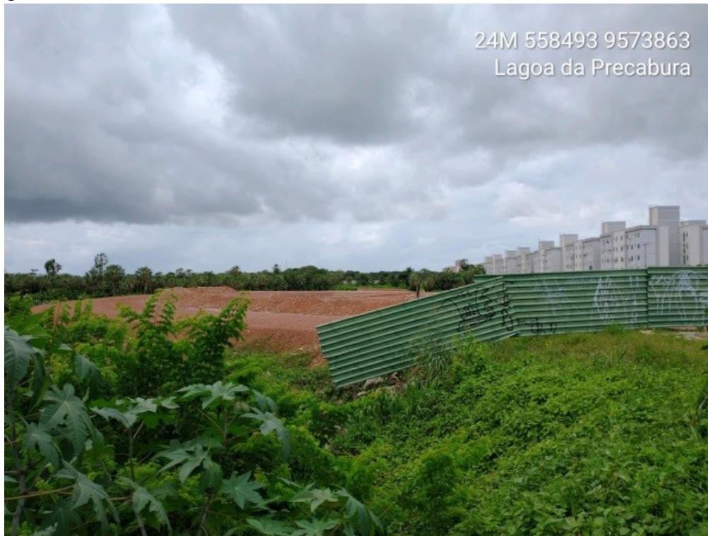
Figura 91 – Aterramento na margem do Rio Coaçu para construção de uma avenida paisagística
