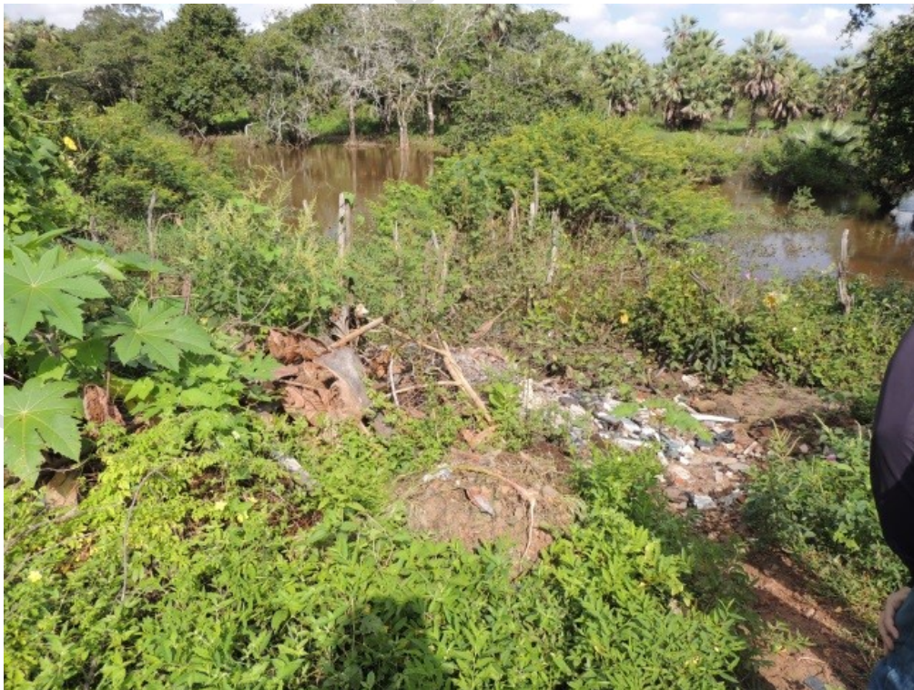
Figura 95 – Disposição inadequada de resíduos da construção civil (RCC) as margens do Rio Coaçu.
