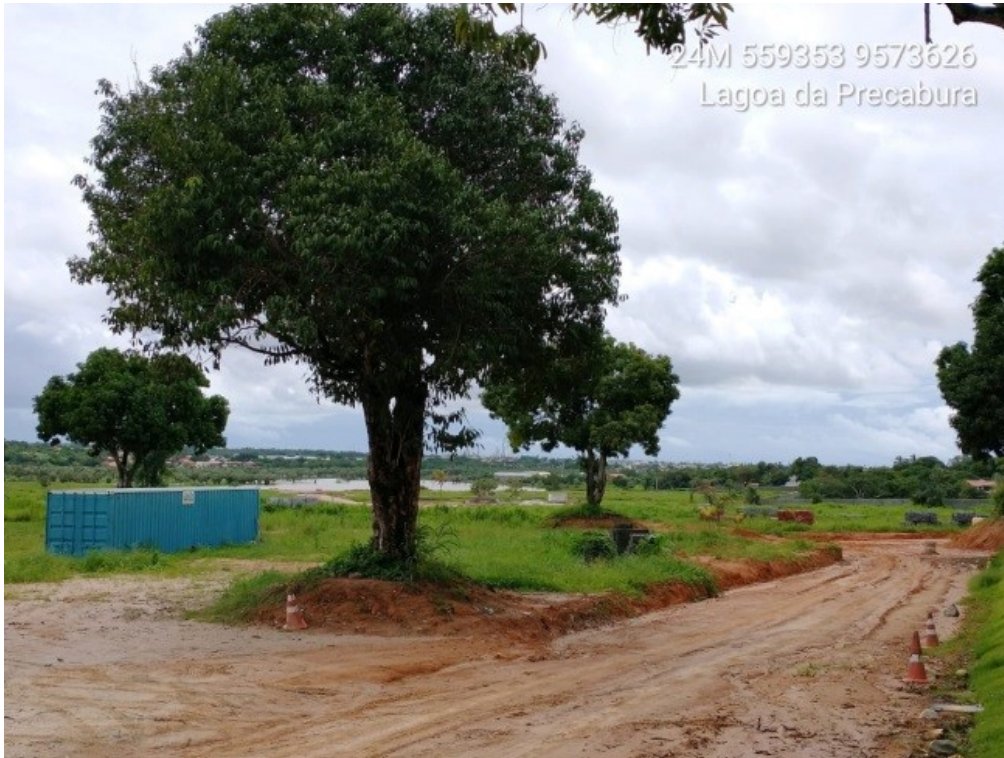
Figura 89 – Construção em andamento na margem do Rio Coaçu.
