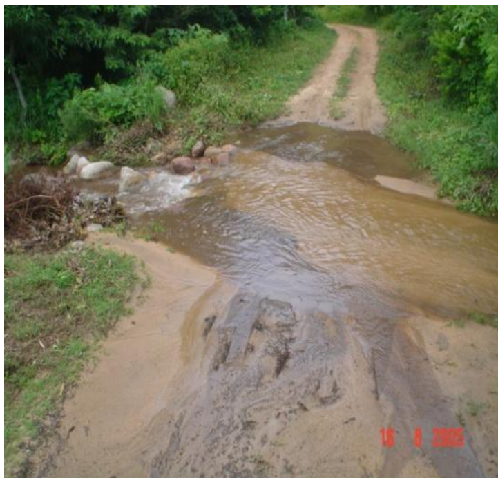
Figura 46. Carretera al ejido 20 de Noviembre, ubicado en la parte alta de la cuenca.
